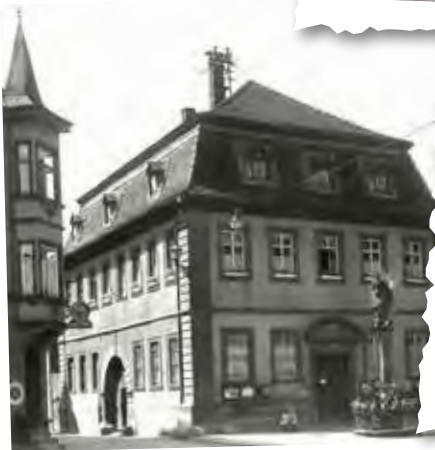
ehemaliges Rathaus Lauda, erbaut 1772
